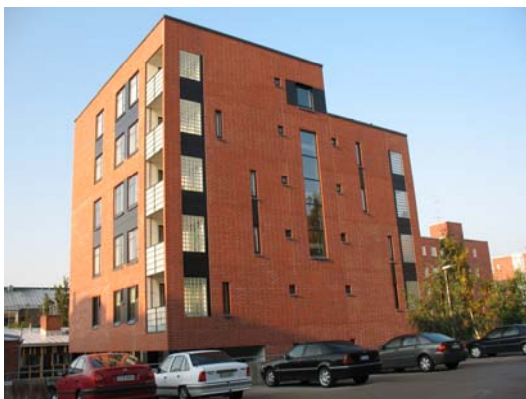
Mur extérieur à carreaux en béton finition "brique".
