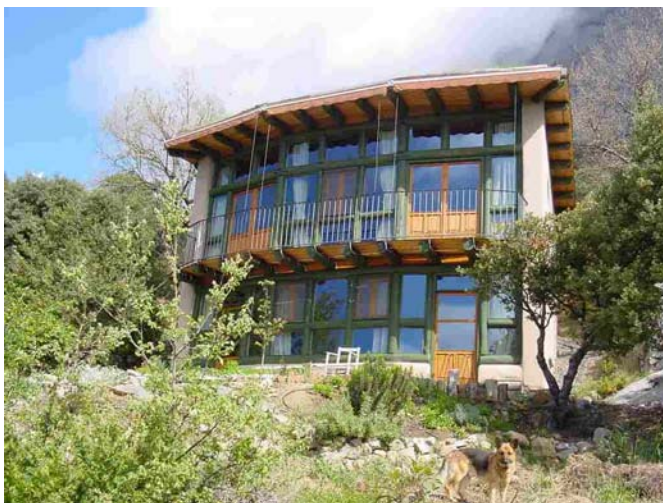
La façade sud vitrée profite du climat et ses 300 jours de soleil par an.
