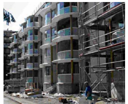
Réfection de logement social à Grenoble, utilisant des balcons vitrés
